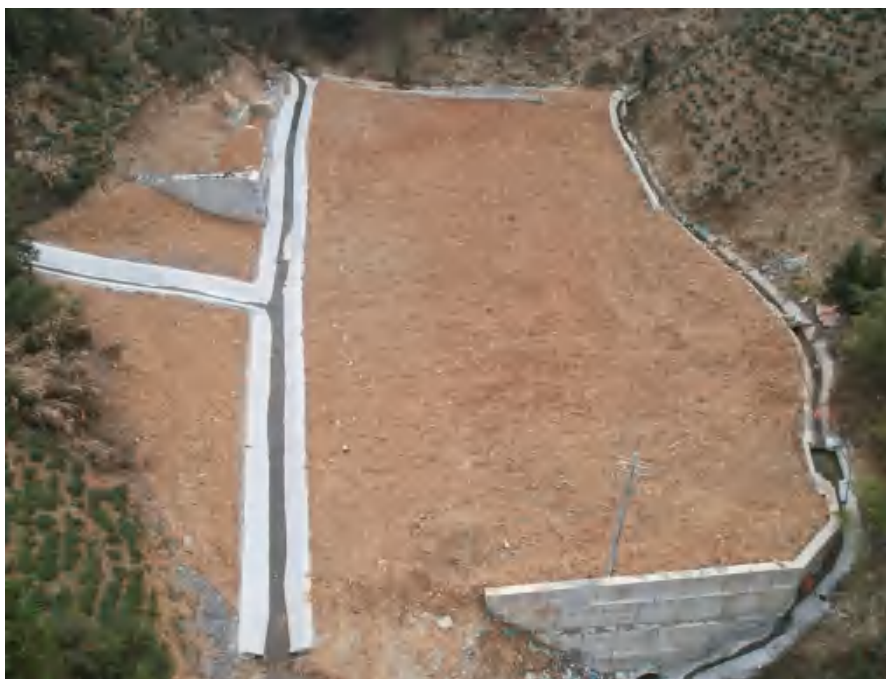
宏村 7#弃渣场施工前中后影像图
