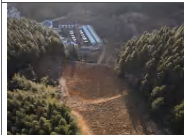
半山出口钢筋棚
