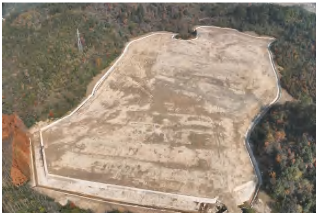
焦村 5#弃渣场施工前中后影像图
