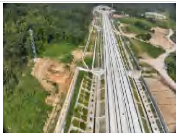
14 号路基边坡绿化
