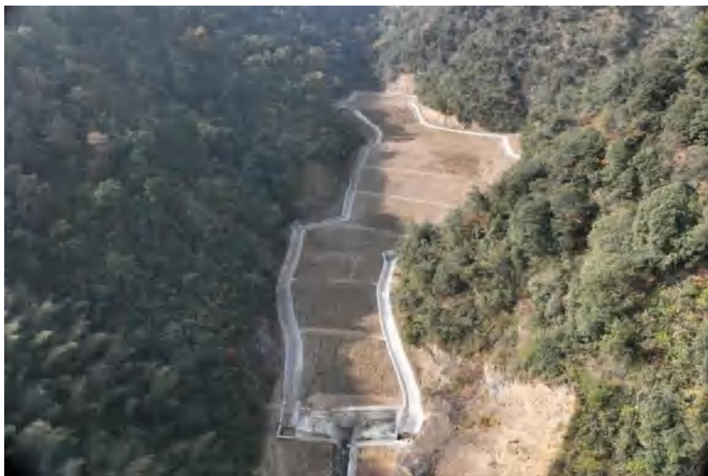
甘棠 12#弃渣场施工前中后影像图
