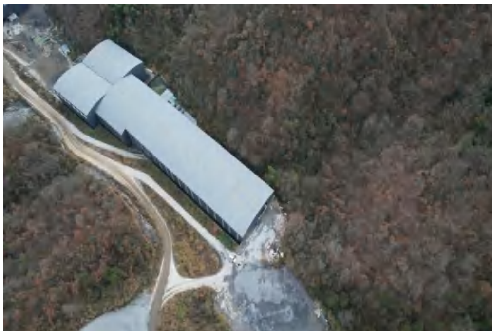
焦村 2#弃渣场施工前中后影像图
