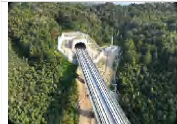
竹木岭隧道洞口防护及绿化
