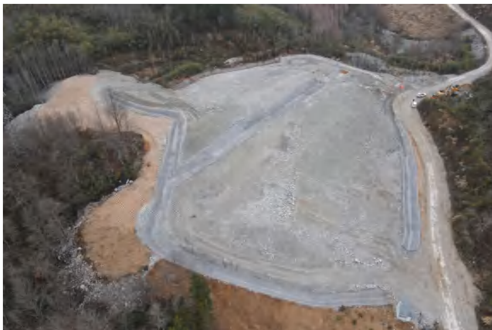
永丰 1#弃渣场施工前中后影像图
