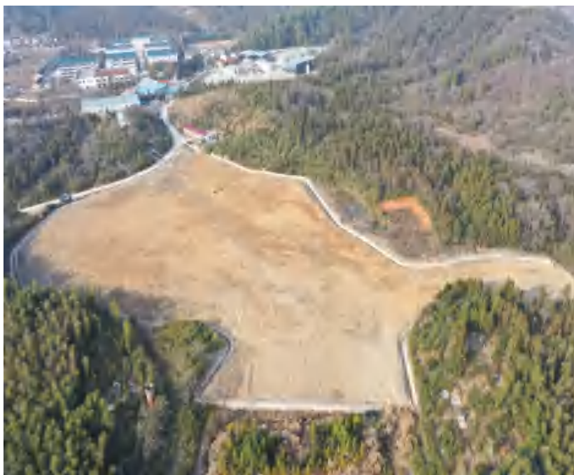
蓉城 1#弃渣场施工前中后影像图
