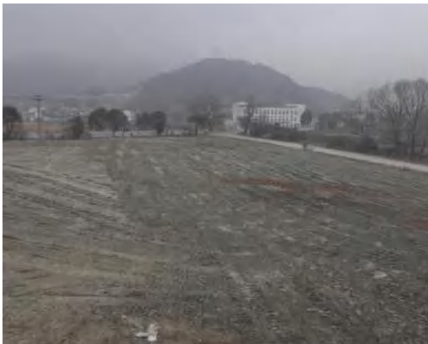
焦村 4#弃渣场施工前中后影像图
