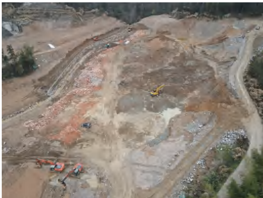
周村弃渣场施工前中后影像图
