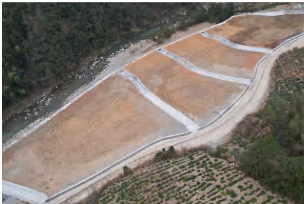
角伍弃渣场施工前中后影像图
