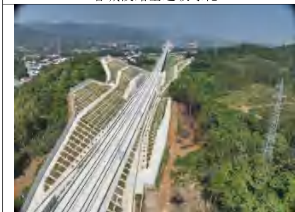
15 号路基边坡绿化
