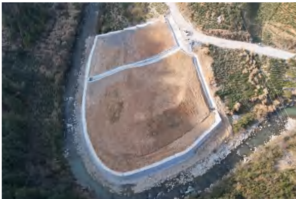
金滩弃渣场施工前中后影像图
