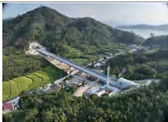
金子坑 1 号隧道洞口防护及绿化
