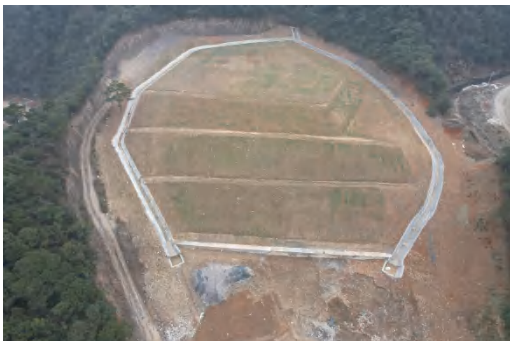
甘棠 4#弃渣场施工前中后影像图
