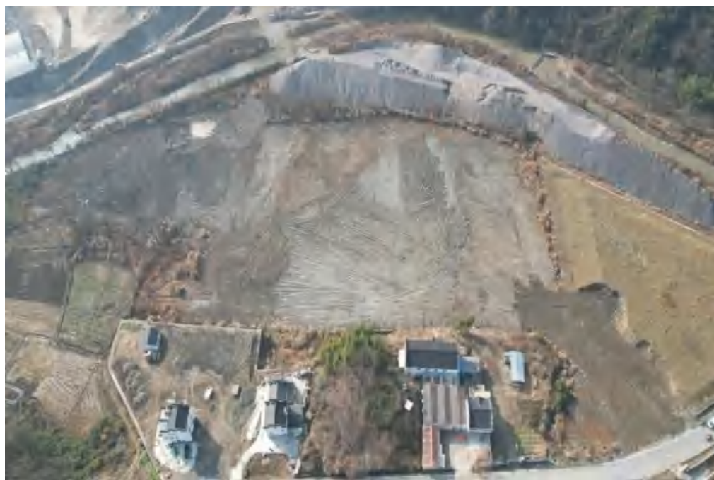
焦村 3#弃渣场施工前中后影像图
