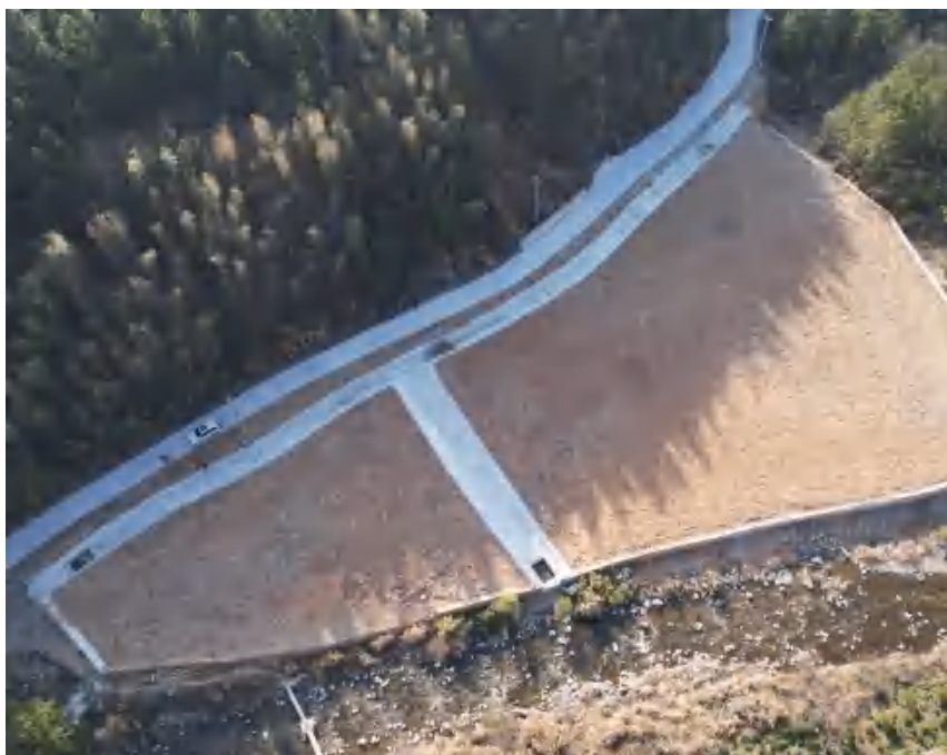
溪头弃渣场施工前中后影像图
