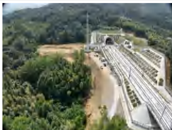
仙隐山隧道洞口防护及绿化
