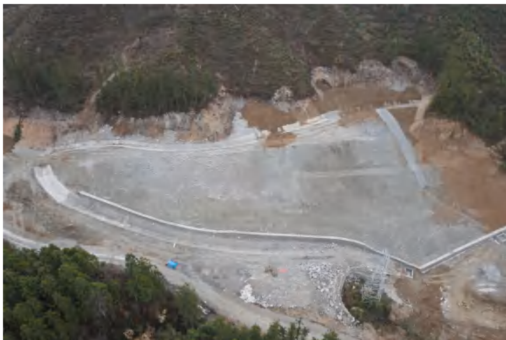
永丰 2#弃渣场施工前中后影像图
