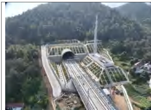
五里冲隧道洞口防护及绿化
