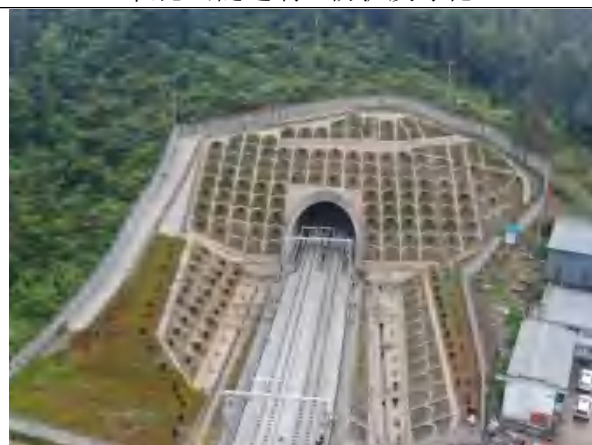
善禾隧道洞口防护及绿化
