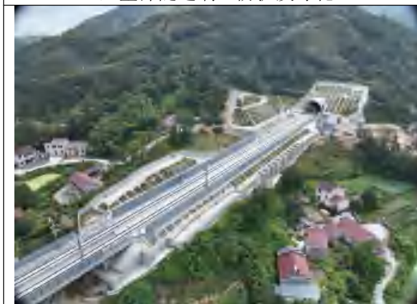
赵家尖隧道洞口防护及绿化
