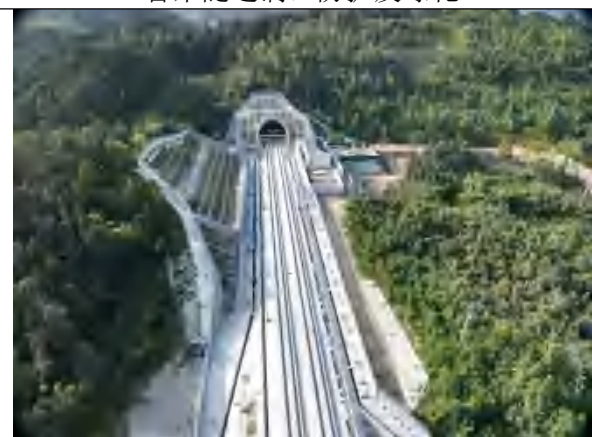
半步岭隧道洞口防护及绿化
