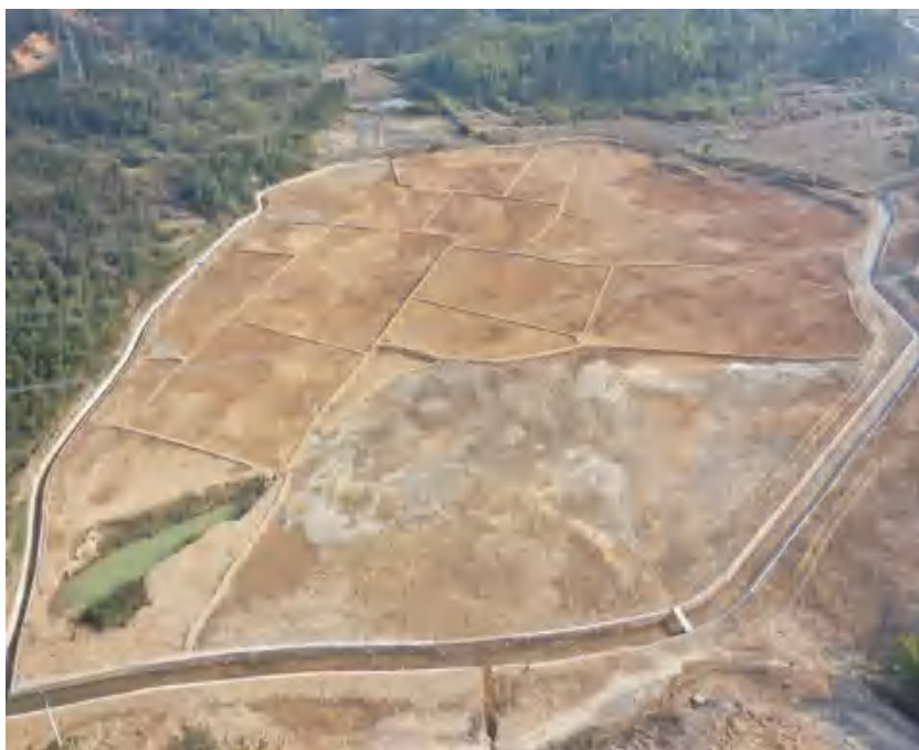
马衙 5#弃渣场施工前中后影像图
