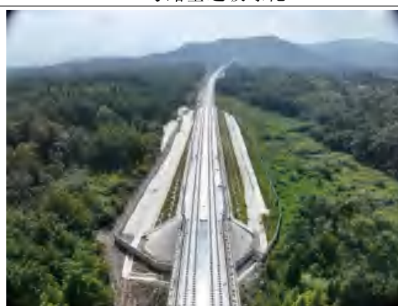
16 号路基边坡绿化
