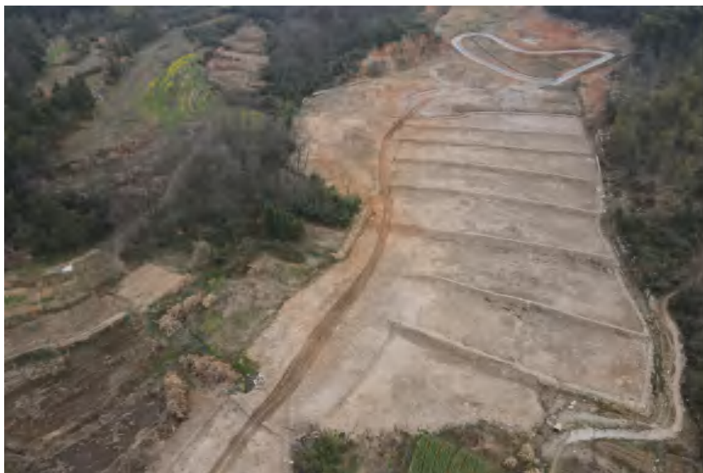
朱备 1#弃渣场施工前中后影像图
