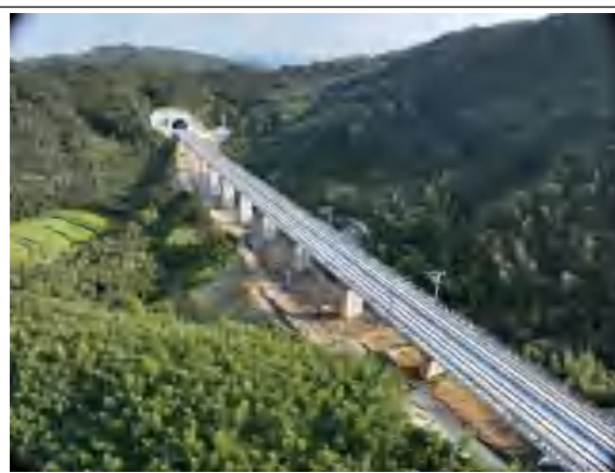
曹村特大桥绿化
