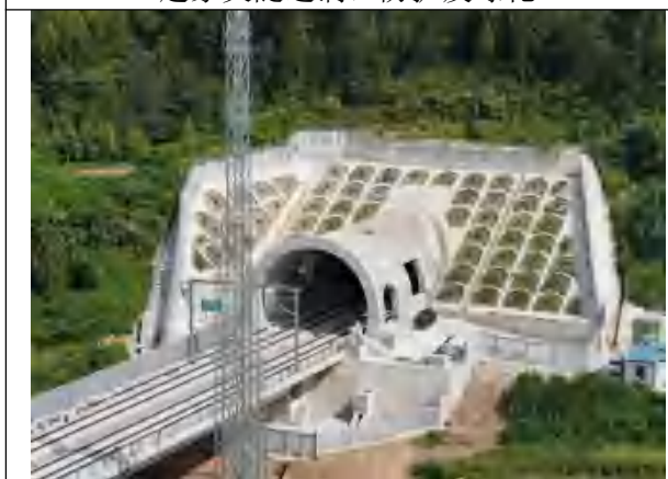
岭上隧道洞口防护及绿化
