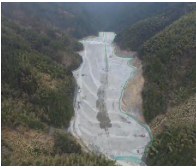
宏村 6#弃渣场施工前中后影像图
