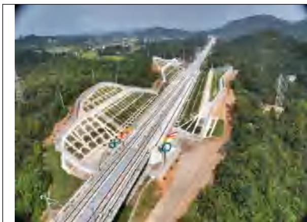
蓉城段路基边坡绿化
